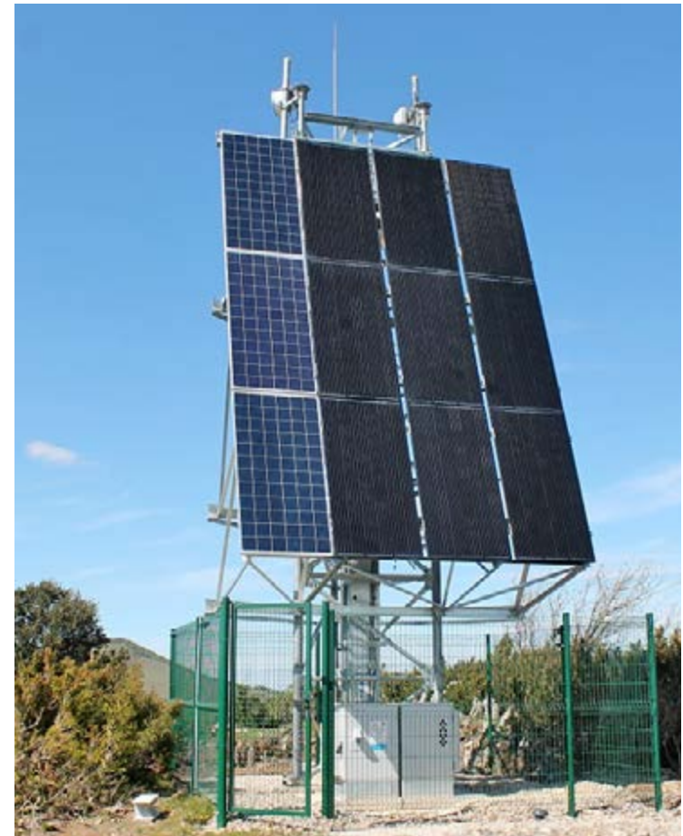
Le recours à l'énergie solaire permet d'installer un répéteur au bon endroit en France.
