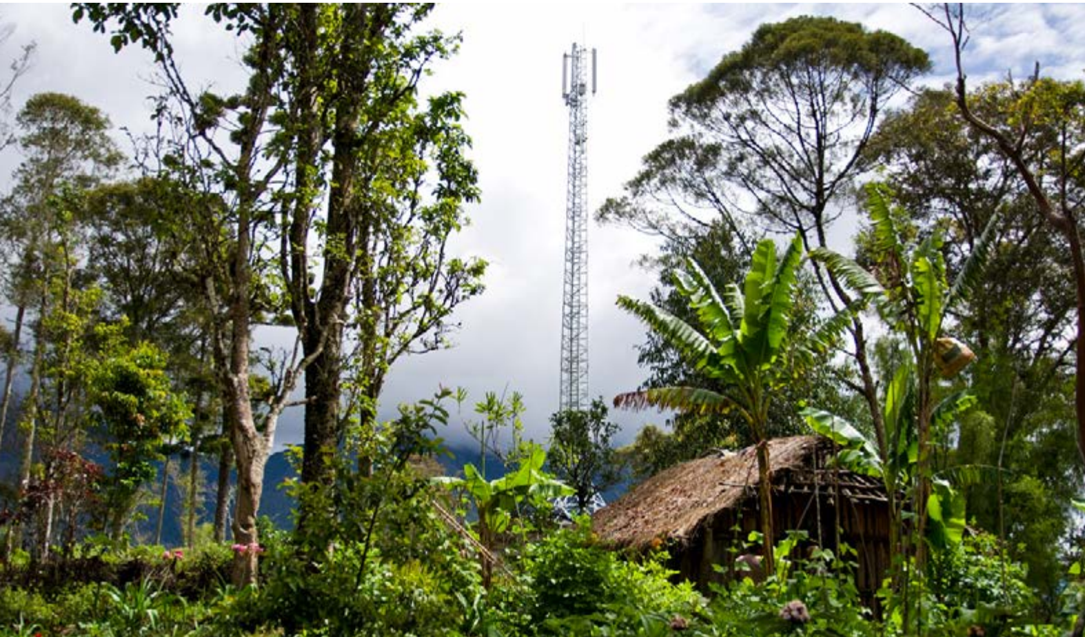
Un système récemment installé dans les montagnes de Papouasie-Nouvelle-Guinée permet de couvrir les besoins en téléphonie cellulaire grâce à l'utilisation de solutions d'énergie solaire.
