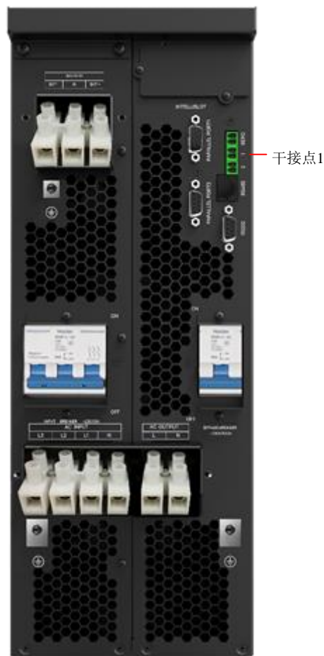
图5-9 短接干接点 1
